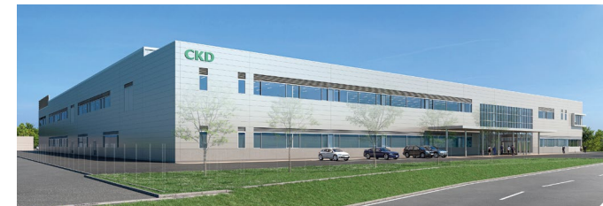
CKD北陸工場(2024年稼働予定)
