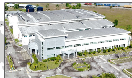
マレーシア工場
