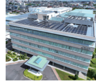
増設設備（本社棟の屋上に設置）
