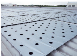
遮熱シートの設置 (CKD日機電装)
