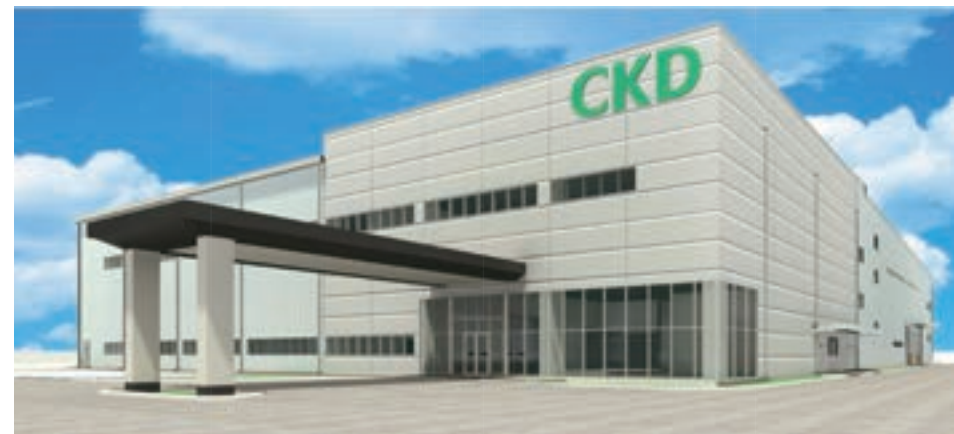
建設中のインド工場（2024年竣工）
