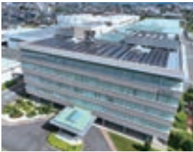
増設設備(本社棟の屋上に設置)
