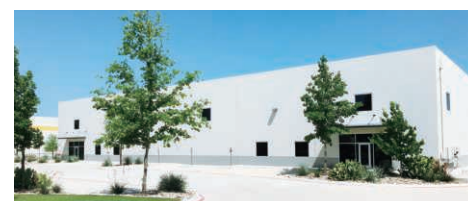
新生産工場の概要 名称：CKD USA Austin Manufacturing 所在地：アメリカ合衆国テキサス州オースティン市 生産品：流体制御機器
