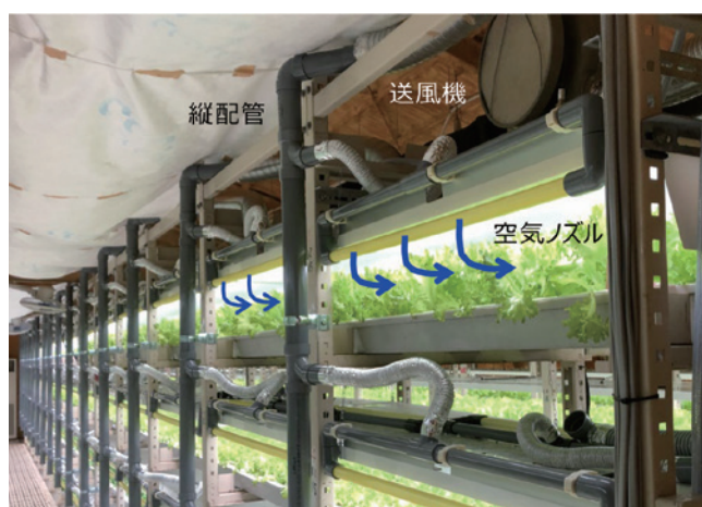
Fig. 1 個別空調システムの導入事例
